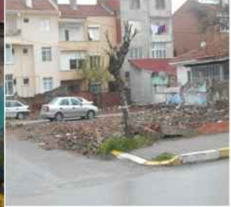
Tespit Edilen Metruk Yapı Yıkım Öncesi Ve Sonrası
